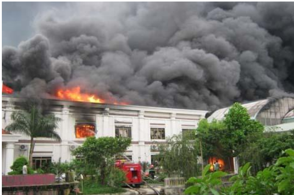
Vụ cháy Nhà máy may của Công ty CP May XK Hà Phong Bắc Giang, ngày 6/4/2013 (tài sản tại kho chứa vải, xưởng may, nhà để xe gồm: vải, quần áo và 2.000 xe đạp, xe máy của CBCNV trên diện tích cháy 3ha bị lửa thiêu trụi)
